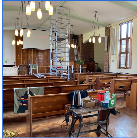
Fitting the AV system
